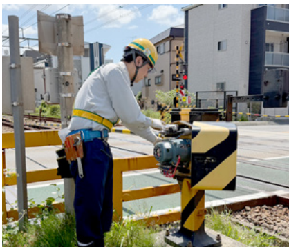
踏切設備の検査
