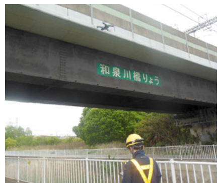
ドローンによる検査
