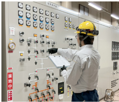
電力設備の検査
