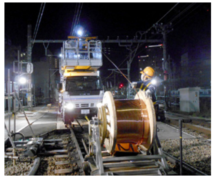
電車線の交換
