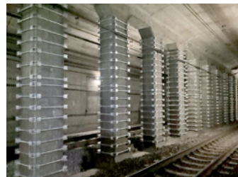
万騎が原トンネルの耐震補強
