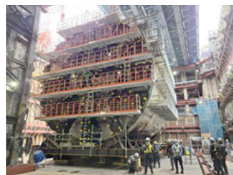
組立中のシールドマシン
