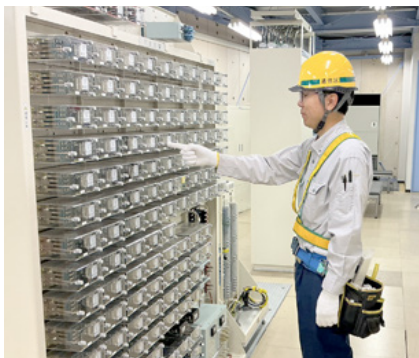
信号設備の検査
