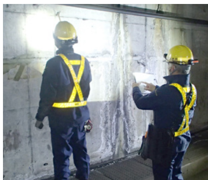
トンネルの検査
