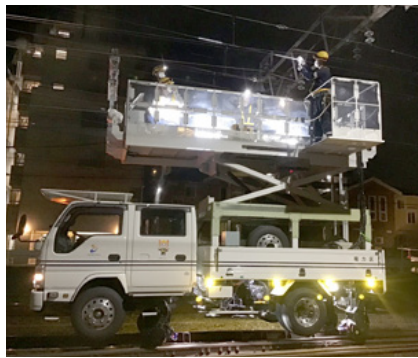
電車線の検査
